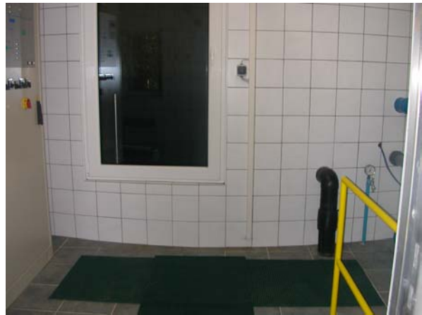
Zugang zum Speicher
