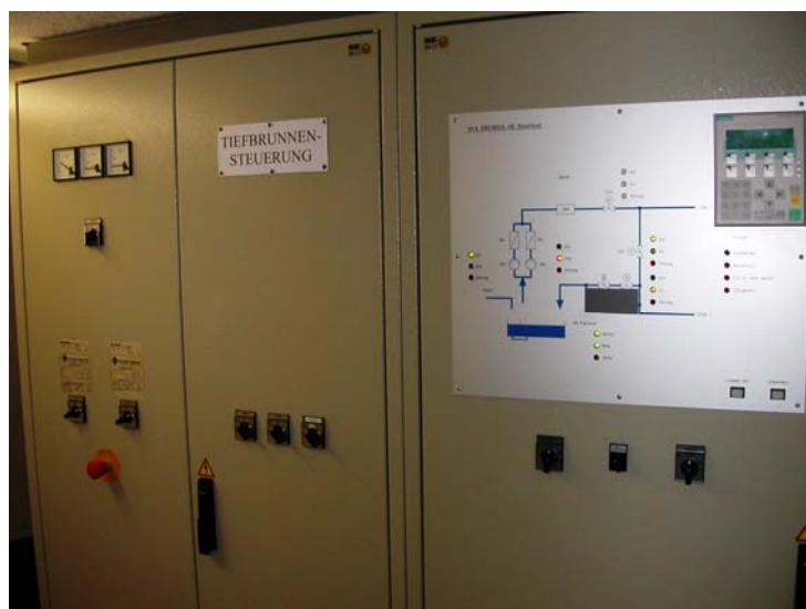
Schaltschrank Fernwirkanlage
