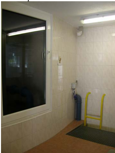
Zugang Speicher Mooshäusl 2
