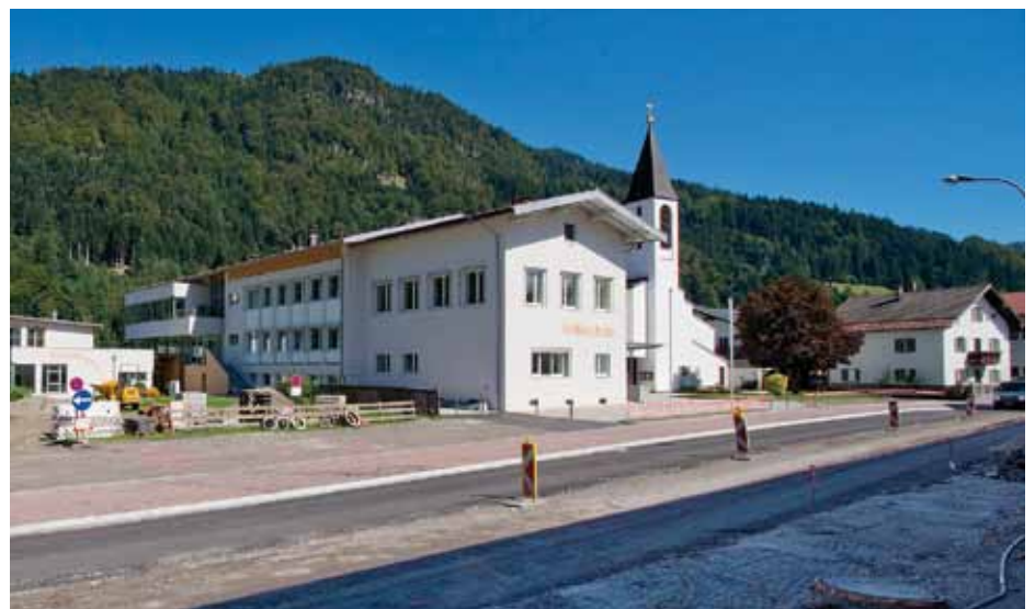
Der Dorfkern Bruckhäusl während des 1. Bauabschnittes
