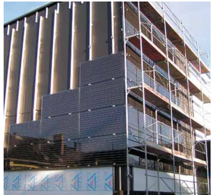
Teilmontage der Fotovoltaikanlage auf der Südwestseite der Turnhalle
