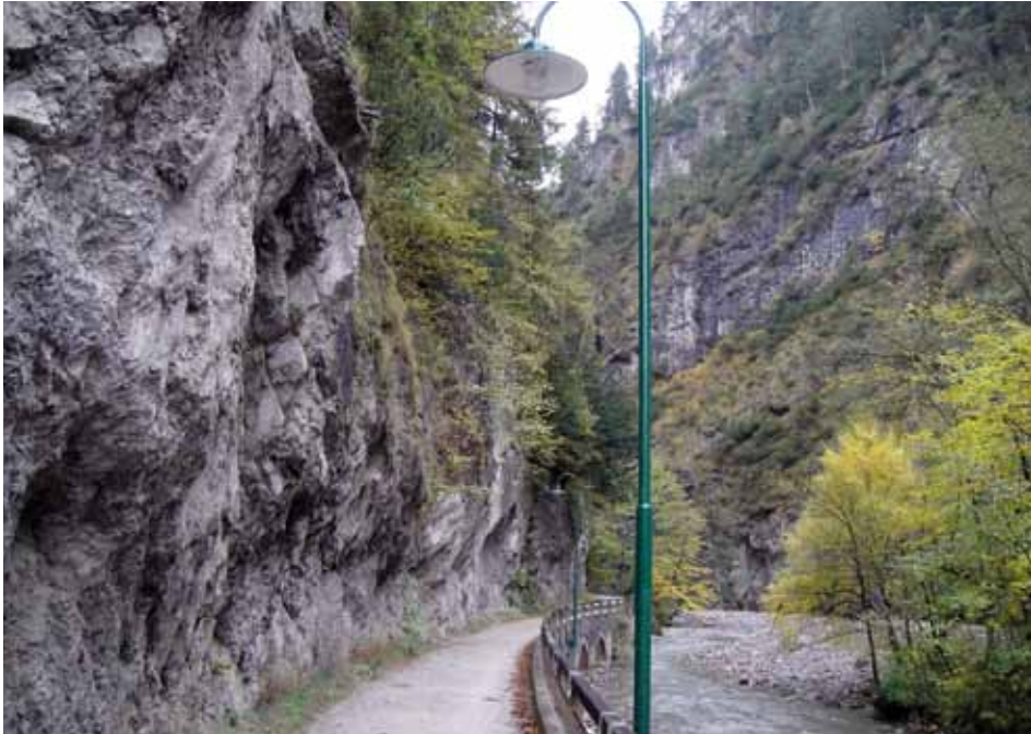
Neue Straßenbeleuchtung bis zum Gasthaus Kundler Klamm
