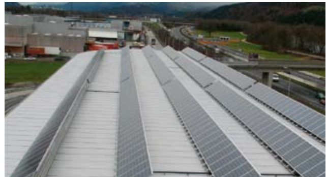
Fotos: Stadtwerke Wörgl
