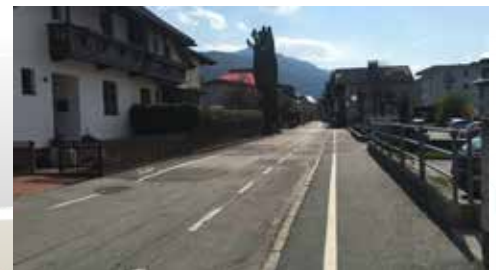
Der gleiche Bereich vor der Umsetzung Foto: Stadtbauamt
