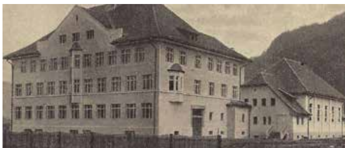
Das fertig gestellte Gebäude - 1928
