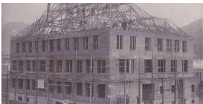
Rohbau der Hauptschule – 1926
