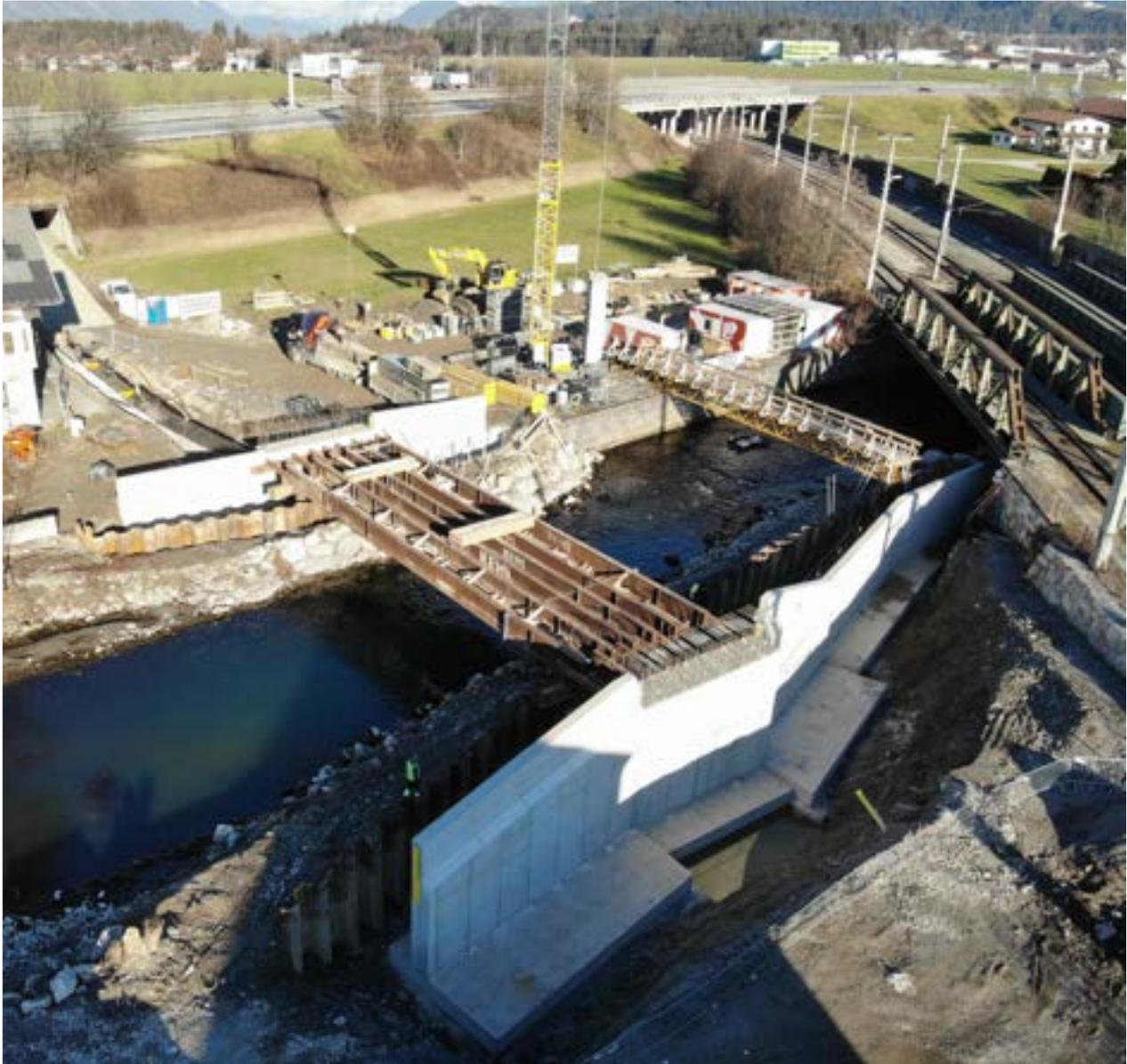
Mit den Bauarbeiten konnte planmäßig am 16. September 2024 begonnen werden. Vor allem auf der Wörgler Seite waren die Umlegungen der Gasleitung und der Starkstromleitung sehr aufwendig. Nach dem Abbruch der alten Brücke am 07. Oktober konnte mit der Baugrubenspundung begonnen werden.
