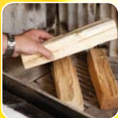
Das Holz locker in den Brennraum schichten.
