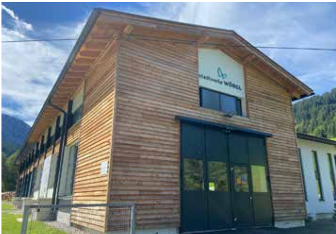
Foto: Stadtwerke Wörgl GmbH
