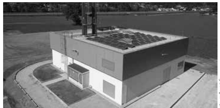
Sonnenschein-Kraftwerkspark IV: Energiezentrale - wörglWÄRME, PV-Mover Kreisverkehr Ost, Umspannwerk Söcking, Umspannwerk Stadtmitte
