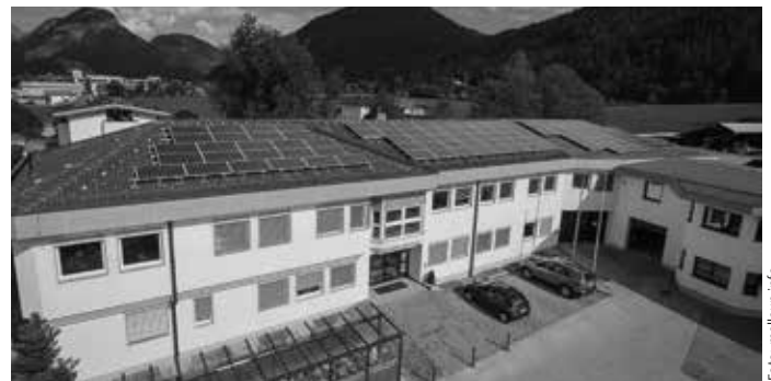
Sonnenschein-Kraftwerkspark II: Bauhof, Bürogebäude | Garage der Stadtwerke Wörgl
